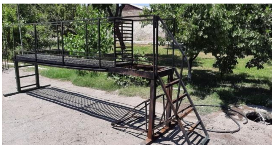
6-расм. Алангадан ўтиш учун бетонли ҳовуз устига ўрнатилган панжарали кўприк.
