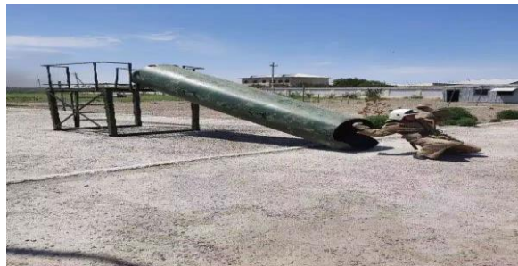
5-расм. Нефт маҳсулотларини куйиш-тўкиш эстакадаси қувури.
