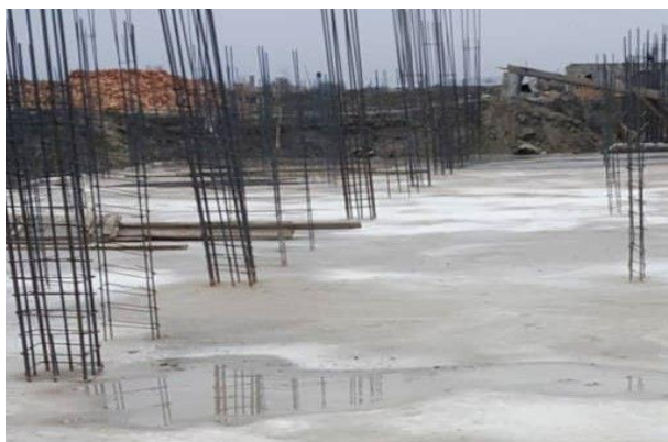
Рис.3. Каркас колонн на уровне этажа и продольные арматуры каркаса здания
