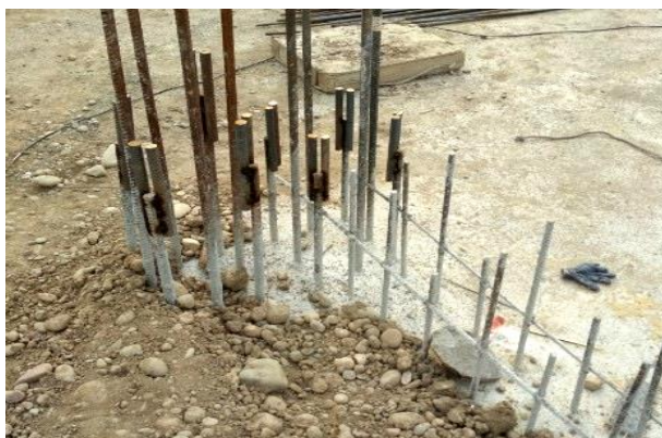
Рис.3. Каркас колонн на уровне этажа и продольные арматуры каркаса здания
