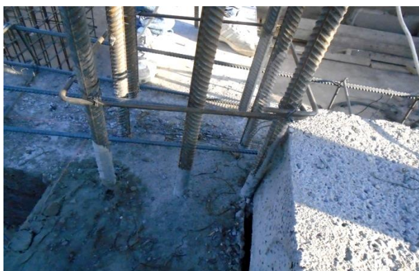
Рис.2. Холодный шов соединения междуэтажных колонн и отклонение колонн от проектной оси
