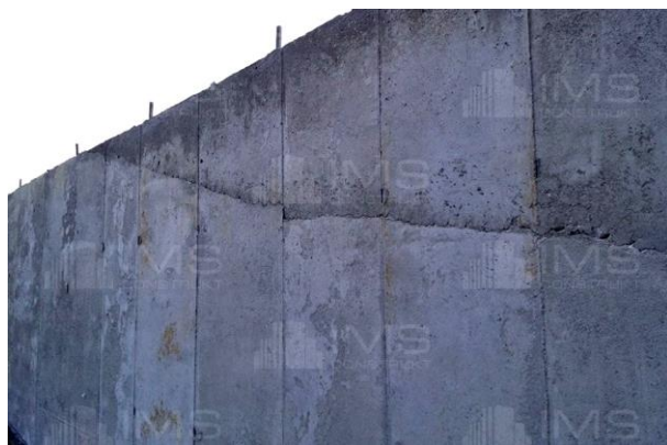
Рис.1. Холодный шов между этажных колонн и отслоение бетона железобетонной монолитной стены
