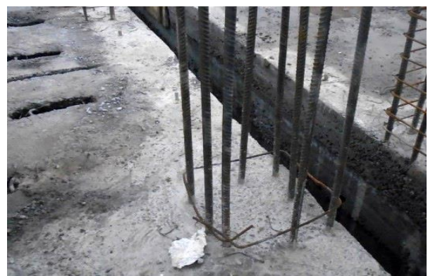
Рис.2. Холодный шов соединения междуэтажных колонн и отклонение колонн от проектной оси
