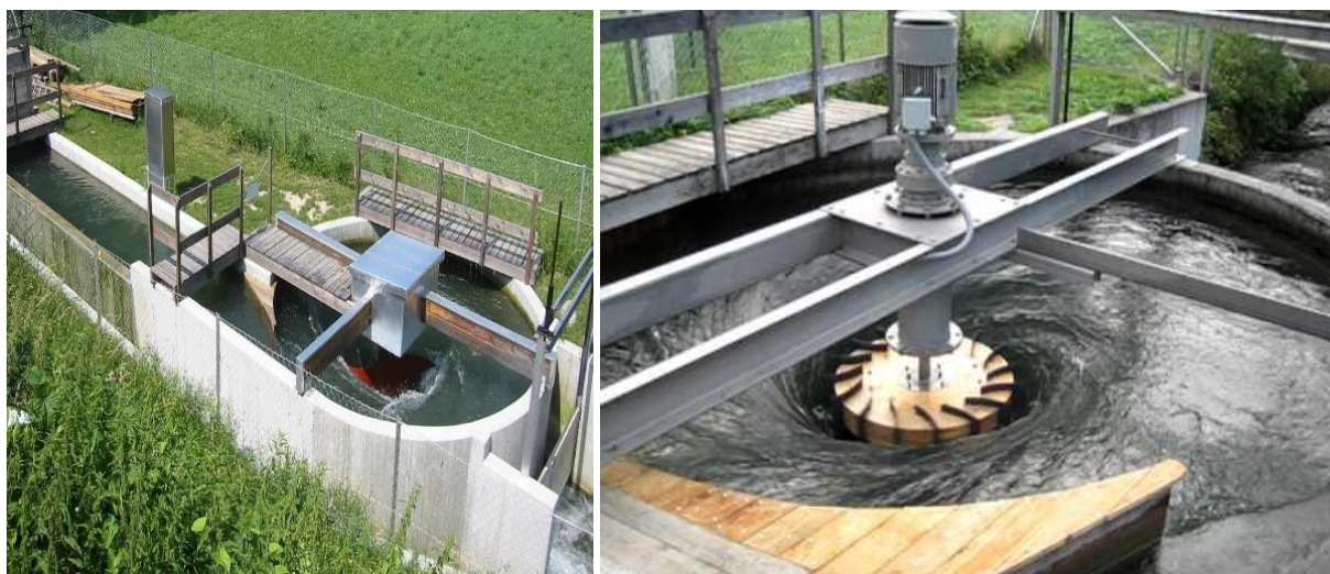
Рисунок 18, 19. Вихревая водяная электростанция, автор проекта и строитель Franz Zotloterer
