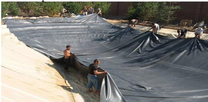
4-rasm. Suv o'tkazmaydigan qoplagich bilan qoplanayotgan hovuz.
