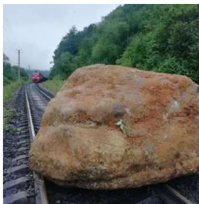
Рис. 5. Камнепад железнодорожного пути.
