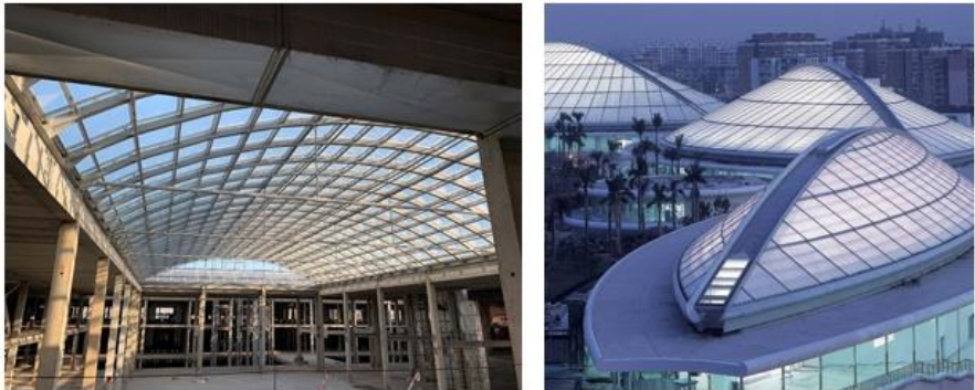
Рис. 1. Будівлі з покрівлею системи Татпроф
