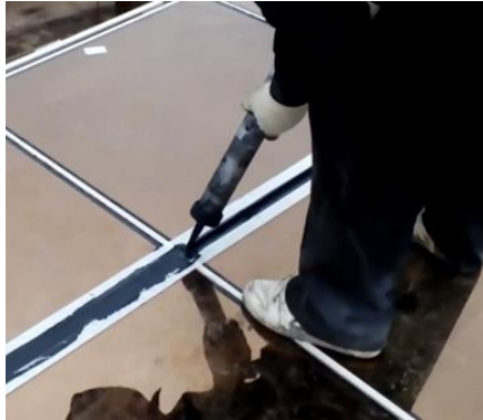
Рис. 5– Нанесення на шви герметика Dou Korning 591
