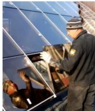
Рис.2 – Монтаж склопакетів (триплекс)
