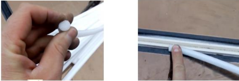
Рис. 3 – Укладання ПВХ ущільнювача серії ТПСК на термовставку ригелю.
