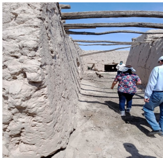
Рис. 4. Галерея-вестибюль, ведущая вглубь комплексного здания
