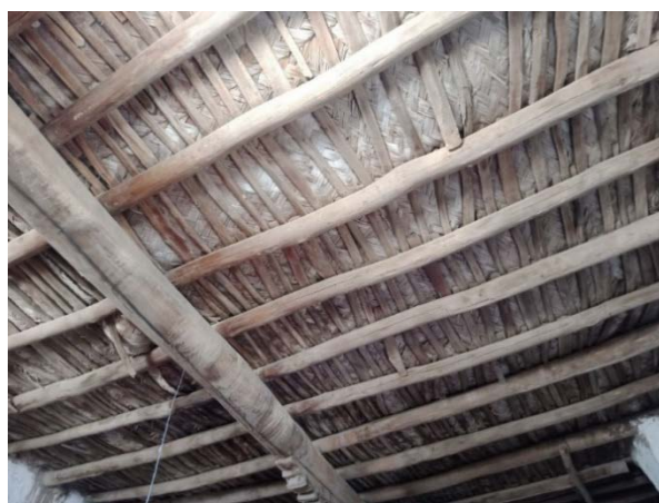
Рис. 5. Мечеть. Конструкция перекрытий в интерьере зала.
