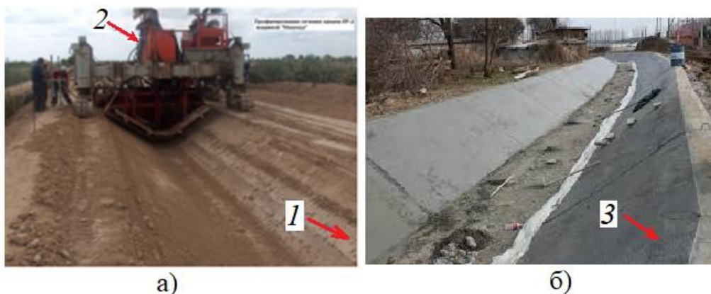
2 - расм. Канал ўзанини бетонлашга тайёрлаш:
