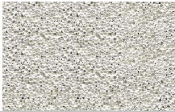
2-rasm. Gaz beton strukturasi.
