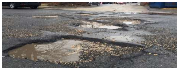
1-rasm. Asfaltbeton qoplamali avtomobil yo'lidagi qoplamaning buzilishi.
