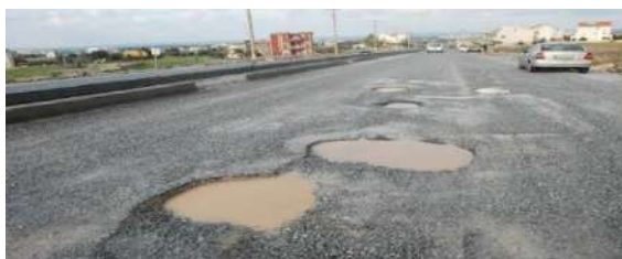
1-rasm. Asfaltbeton qoplamali avtomobil yo'lidagi qoplamaning buzilishi.
