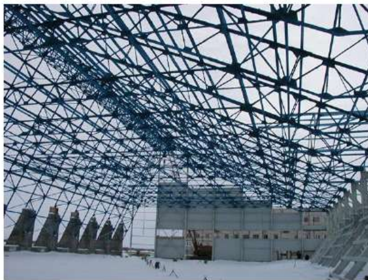
Рис. 12. Усиленный металлический каркас спортивного сооружения
