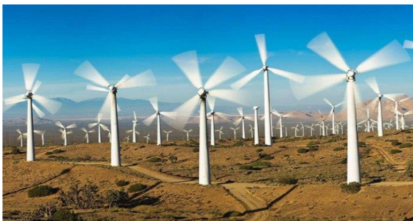
1-rasim shamol elektr stansiyasining umumiy ko'rinishi.
