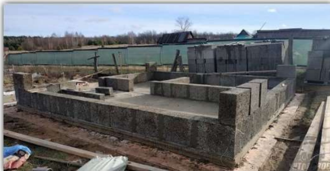
1-rasm. Arbolit betonning binolar qurilishida ishlatilishi
