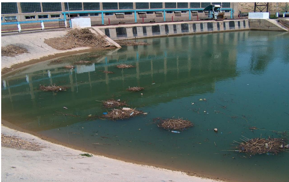
1- расм. Насос станция аванкамерасидаги сувда оқиб юривчи чиқиндилар ҳолати.
