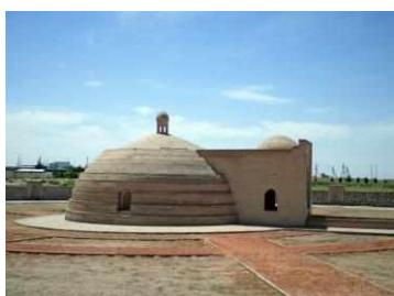
**SARDOBA** (fors. toj. sard — sovuq va ob — suv) — suv tanqis hududlarda uni to‘plash va saqlash uchun maxsus qurilgan gumbazli hovuz.
